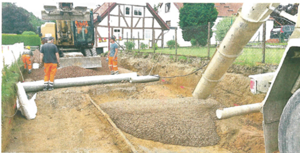
In der Seidenstickerstraße in Grünenplan wird Flüssigboden eingesetzt, der dann aushärtet.
