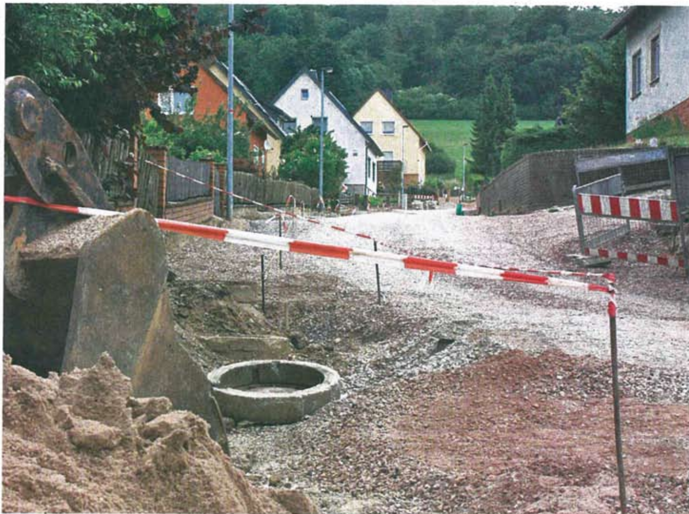
Im Eingangsbereich der Straße stoßen die Bauarbeiter auf eine Drei-Kammern-Klärgrube.
