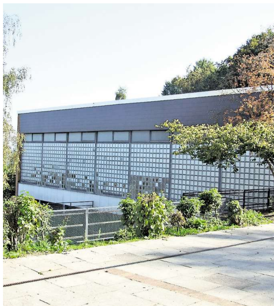
Die Stadt will auch Sanitärbereich und Fassade der Turnhalle sanieren.
