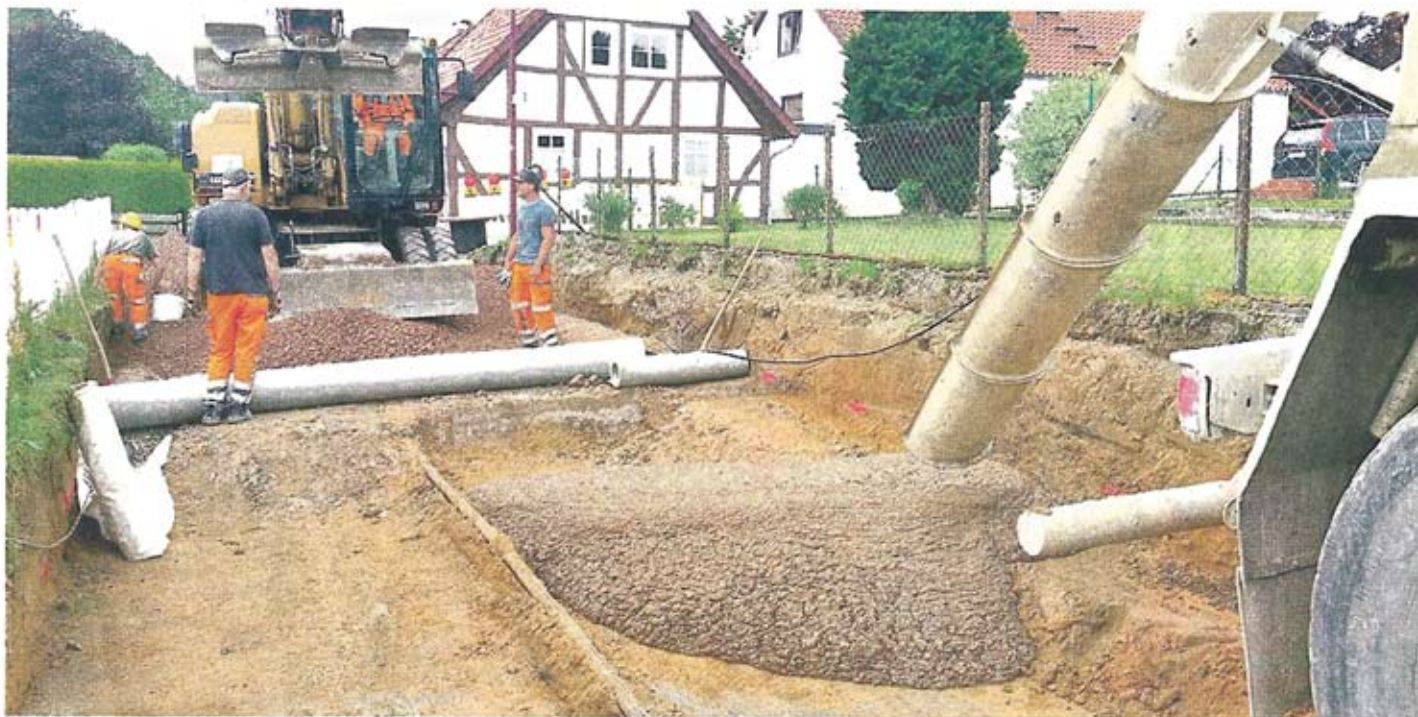
In der Seidenstickerstraße in Grünenplan wird Flüssigboden eingesetzt, der dann aushärtet.
